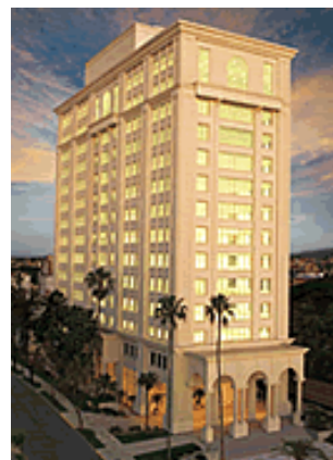
Fig.2 - Edifício em “estilo neoclássico”, Porto Alegre
